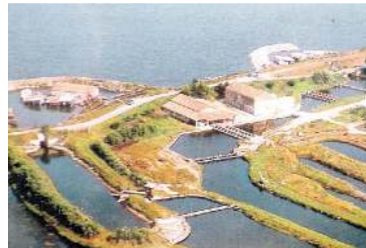
DELTA DEL PO Il parco è entrato nella rete mondiale dei Musei dell'Acqua, che comprende una sessantina di enti
